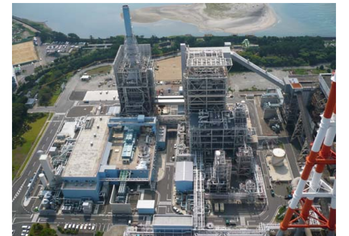
IGCC実証機全景
