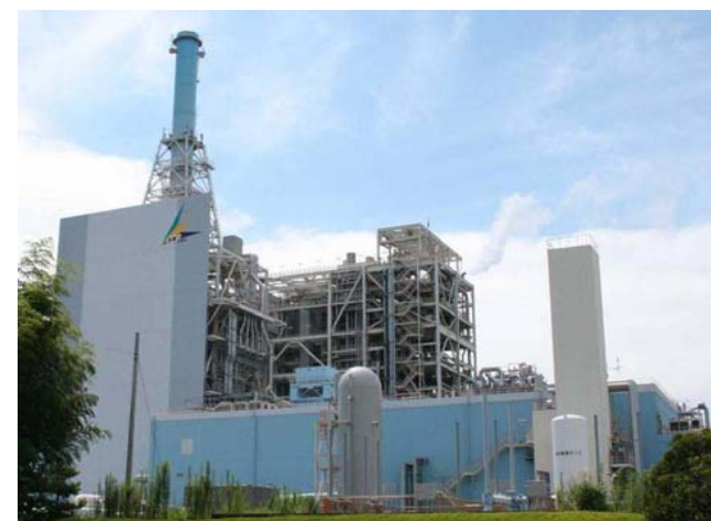
IGCC実証機外観
