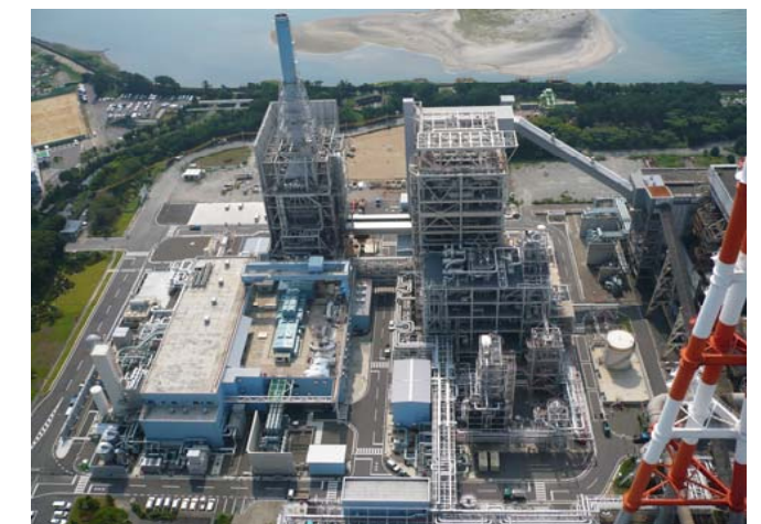
IGCC実証機の全景
