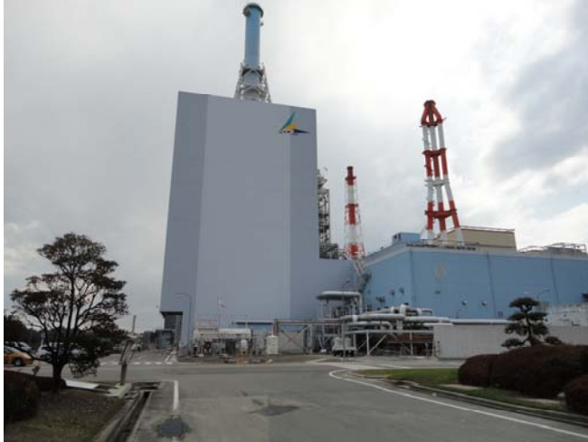
②near by HRSG (heat recovery steam generator) (4/28) ( Fig 6)
